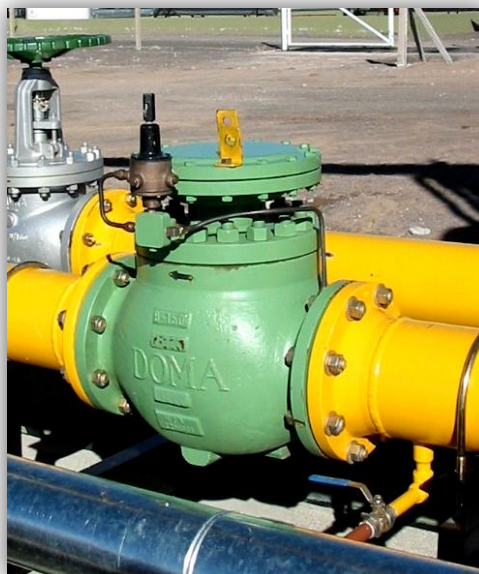
Fig. 2: Regulador 63EF Ø 8" 150#.
