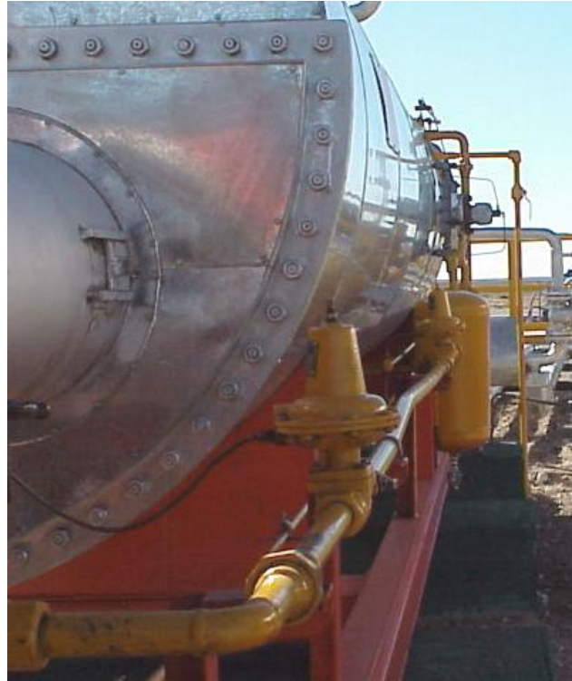
Fig. 2: Aplicación típica, en calentador de fuego indirecto.
